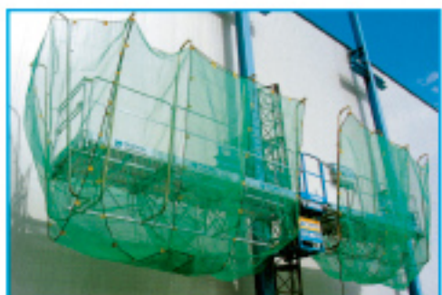
Sistema de protección ANTI-CALDA de objetos / Protection FROM FALLING objects / Système de protection ANTICHAUTE d'objets
